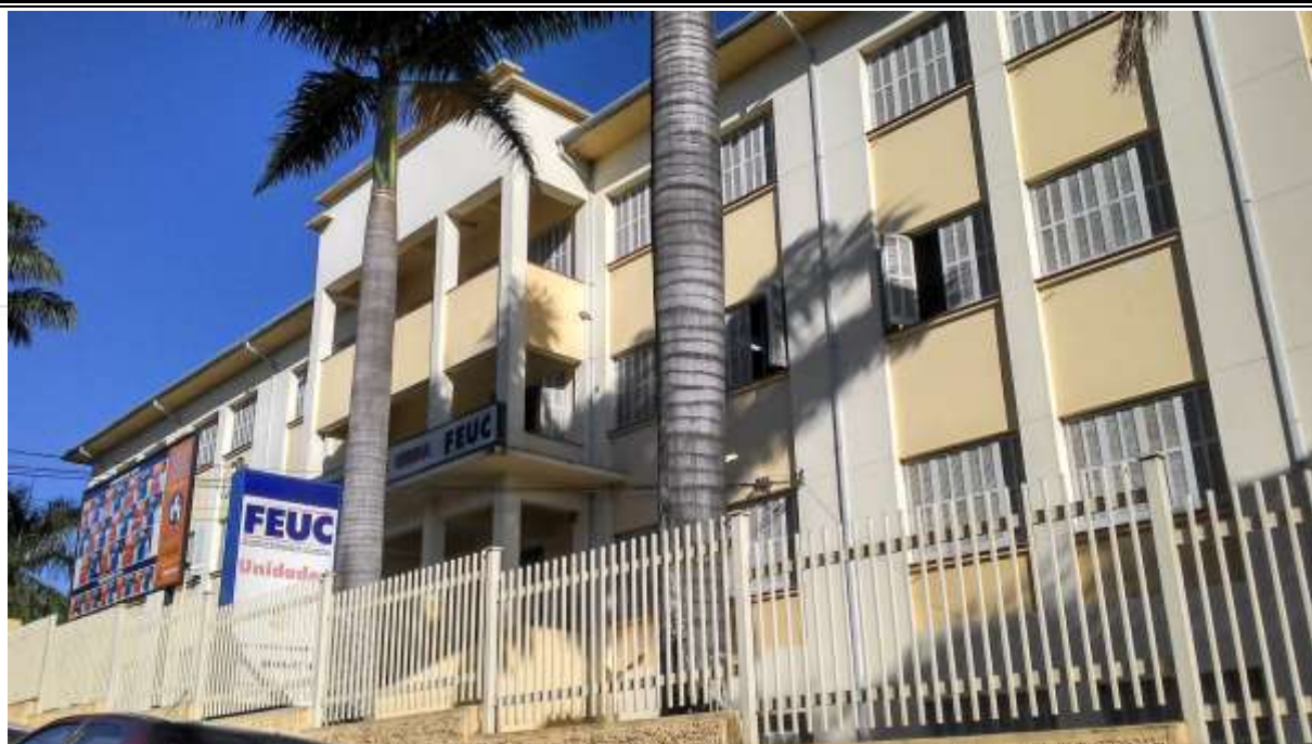
Imagem 25 – Prédio da Unidade I da FEUC
