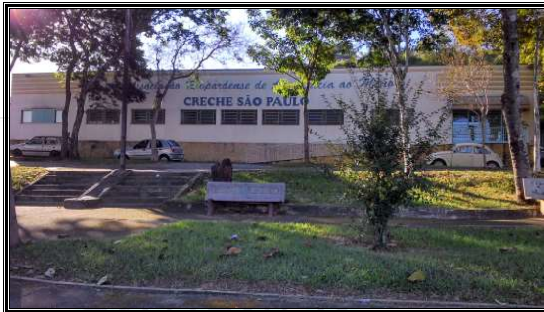
Imagem 18 – Prédio da Creche São Paulo, onde funciona, também, a EMEB Alexandra Olga Pourrat
