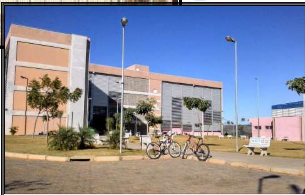
Imagem 23 – Prédio da ETEC Centro Paula Souza
