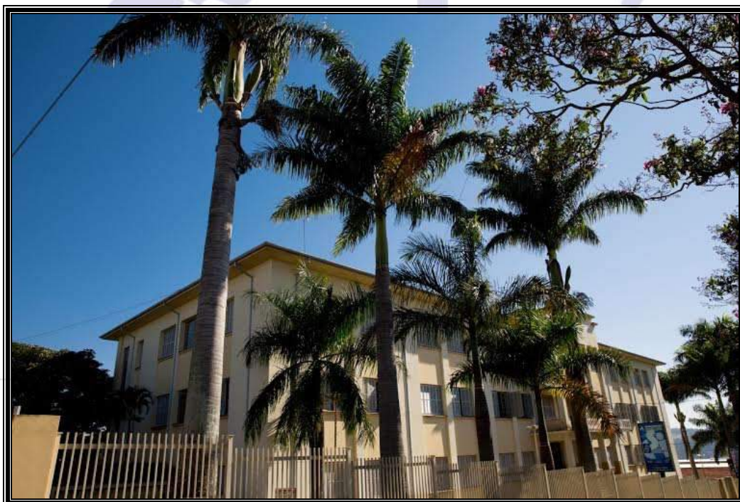
Imagem 14 – Prédio da Congregação Filhas de Nossa Senhora do Monte Calvário, onde funciona o Colégio Santa Inês.
